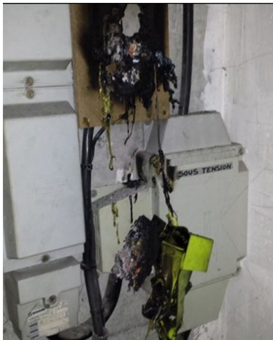
L'un des deux compteurs qui a brûlé dans la résidence des Jardins du Pech. / Photo DR, Ch.J.
