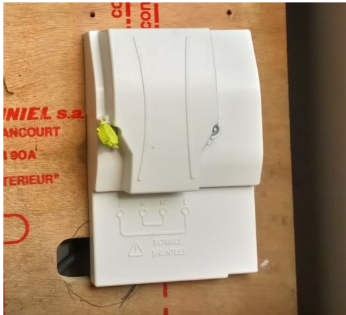
Le module de raccordement posé mercredi 6 décembre.
